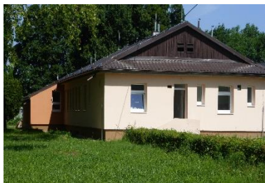
Rekonštrukcia materskej škôlky
