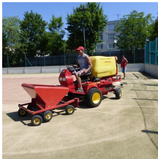
Oprava multifunkčného ihriska
