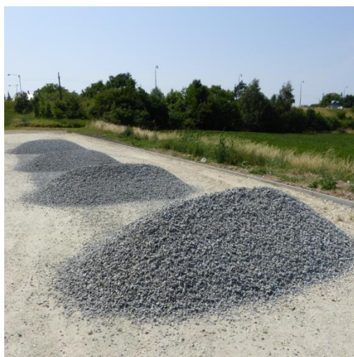
Oprava parkoviska pri cintoríne
